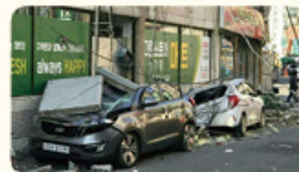
낙하물 차량 파손
