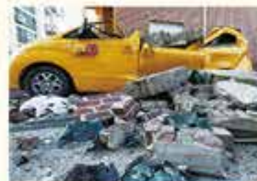
• 조계도 외벽 파손으로 인한 차량파손
