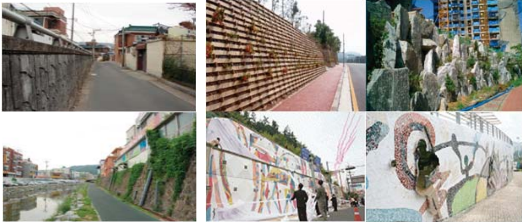
기존 도로변 옹벽
