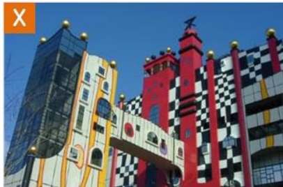
환경시설 건물 벽면의 과도한 그래픽
