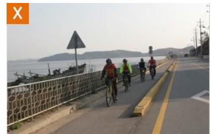
노면표지가 없는 자전거 도로
