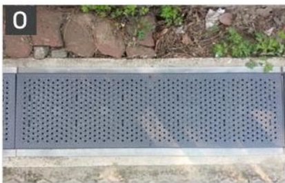
0 덮개의 표면이 보도와 동일한 높이로 설치
