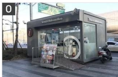
휠체어 접근을 고려한 경사로 설치
