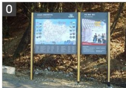
경사로에도 수평을 유지하도록 설치
